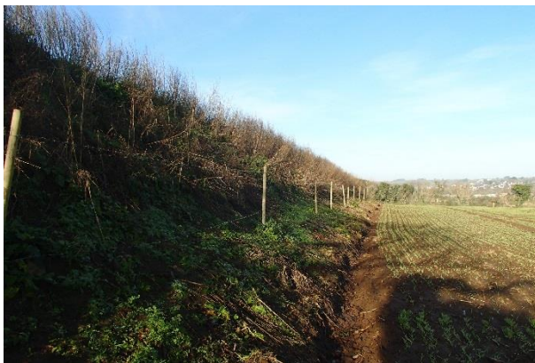
Prise de vue du merlon sud-ouest, bordant la carrière © THEMA Environnement
